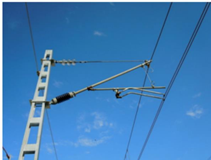
Ilustración 4.77.- Modelo de catenaria CA – 220
