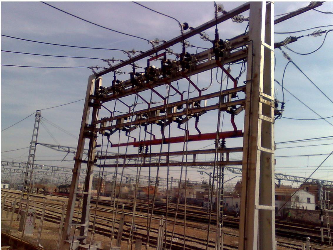
Ilustración 4.27.- Pórtico de feeders
