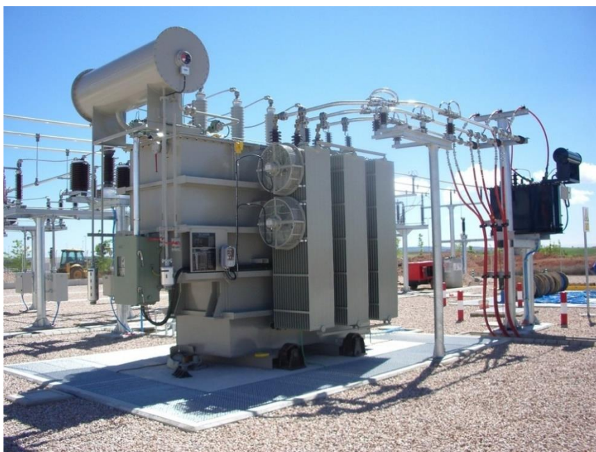
Ilustración 4.38.-Transformador de tracción dispuesto en una subestación de tracción en corriente alterna. Fabricante: ALKARGO
