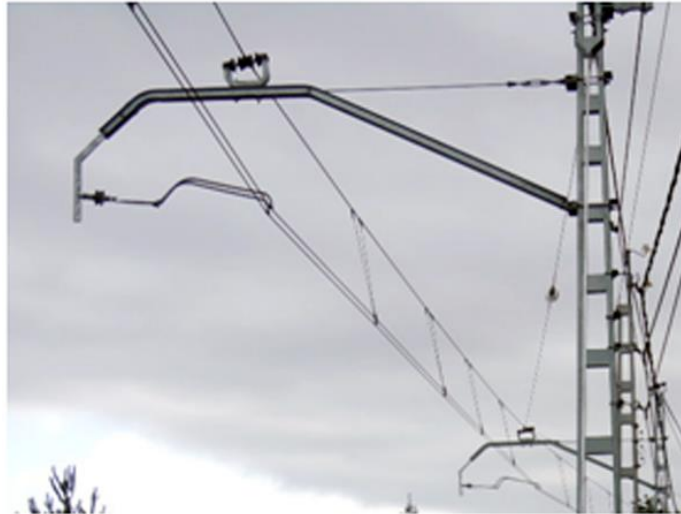
Ilustración 4.76.- Modelo de catenaria CA – 160
