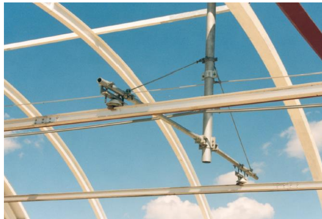
Ilustración 4.58.- Catenaria rígida
