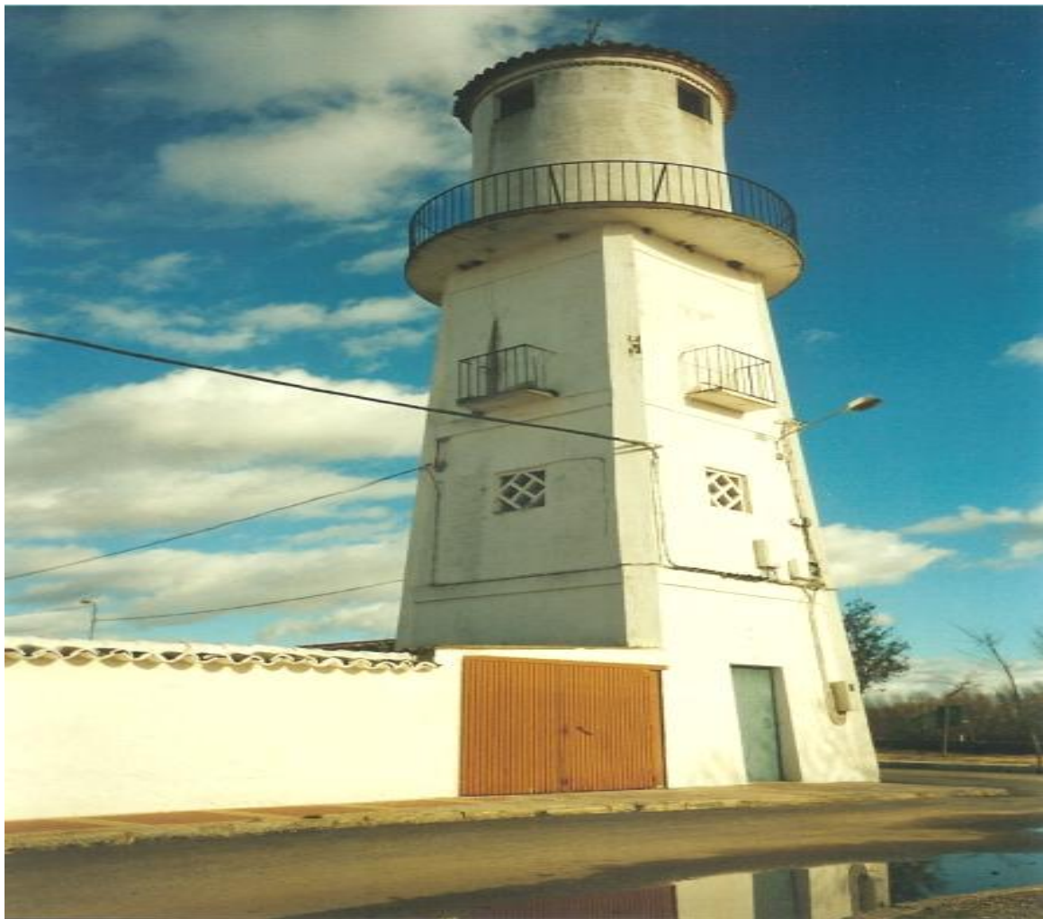
Foto: Depósito de agua de Los Villares (foto propia)
