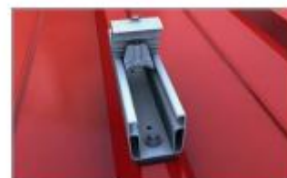
Pinza final en el rail corto C47
