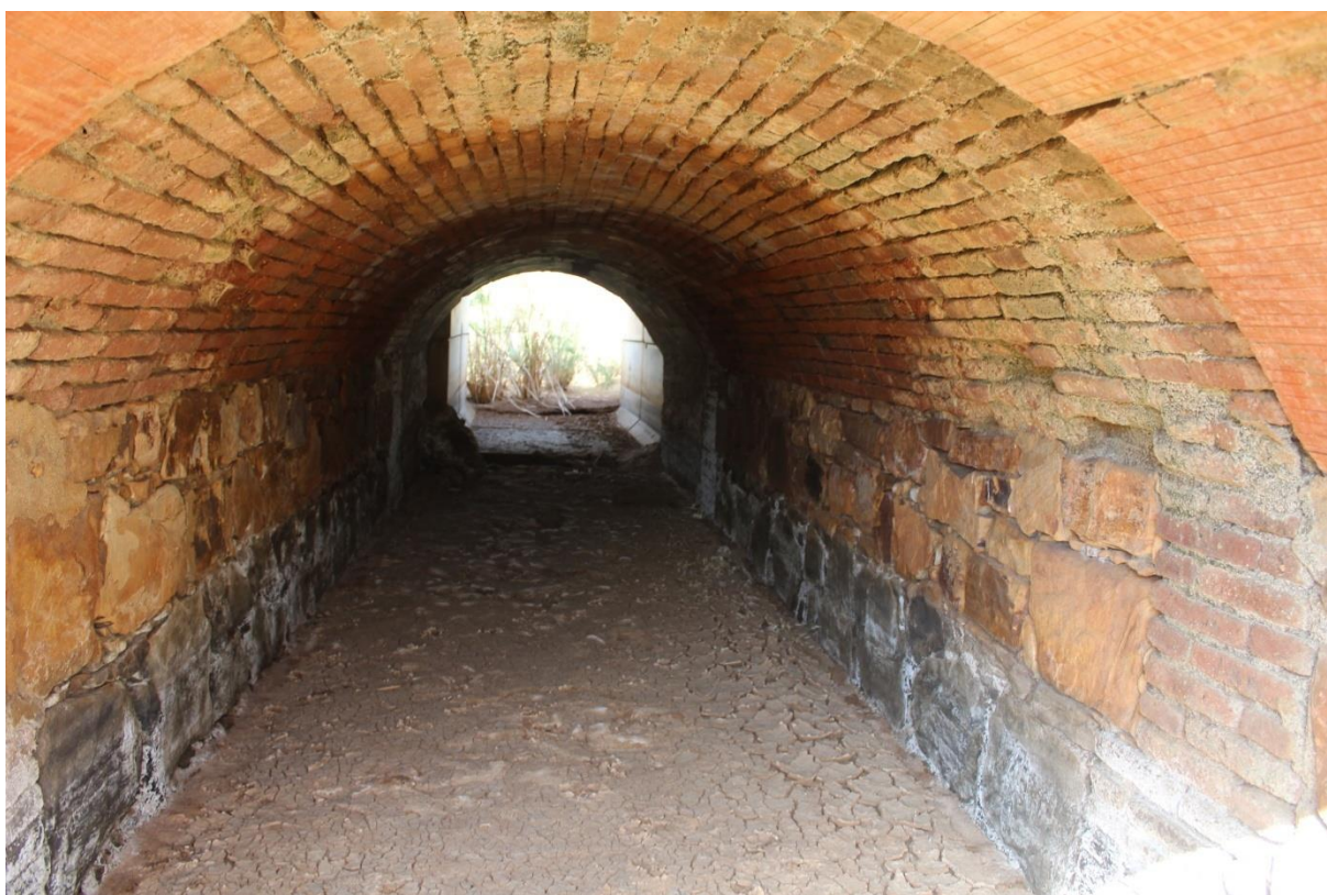
Fotografía 6. Estructuras de paso de los arroyos bajo las carreteras y las vías del tren.
