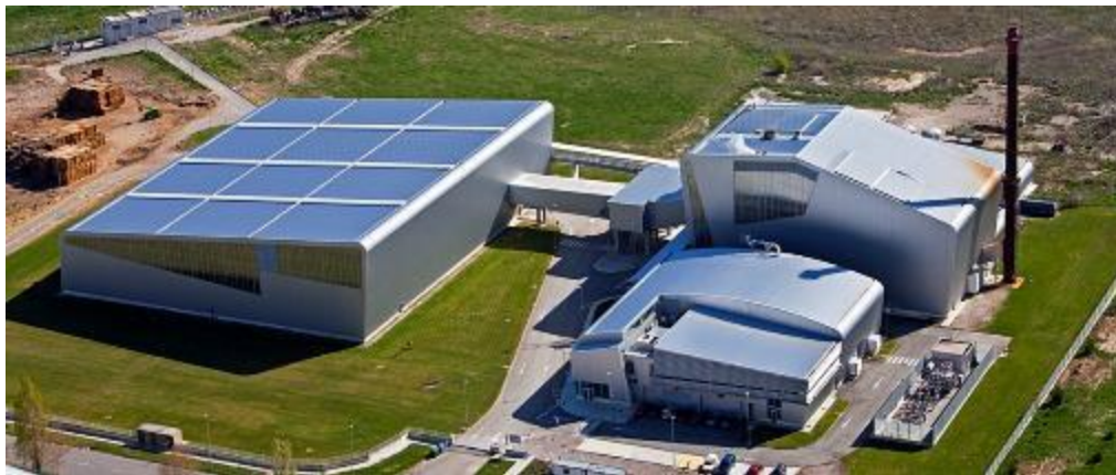
Figura 2.14 Planta Sagüesa, Navarra. Fuente: http://www.accion-energy.com/es/areas-de-actividad/otras-tecnologias/biomasa/instalaciones-destacadas/planta-de-biomasa-de-sanguesa/ .
