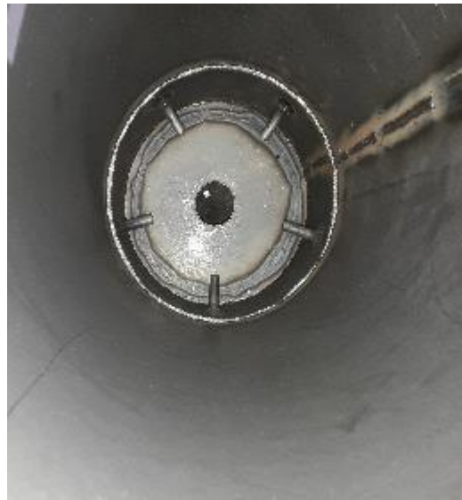
Figura 4.11 Exterior e interior del Hopper.
