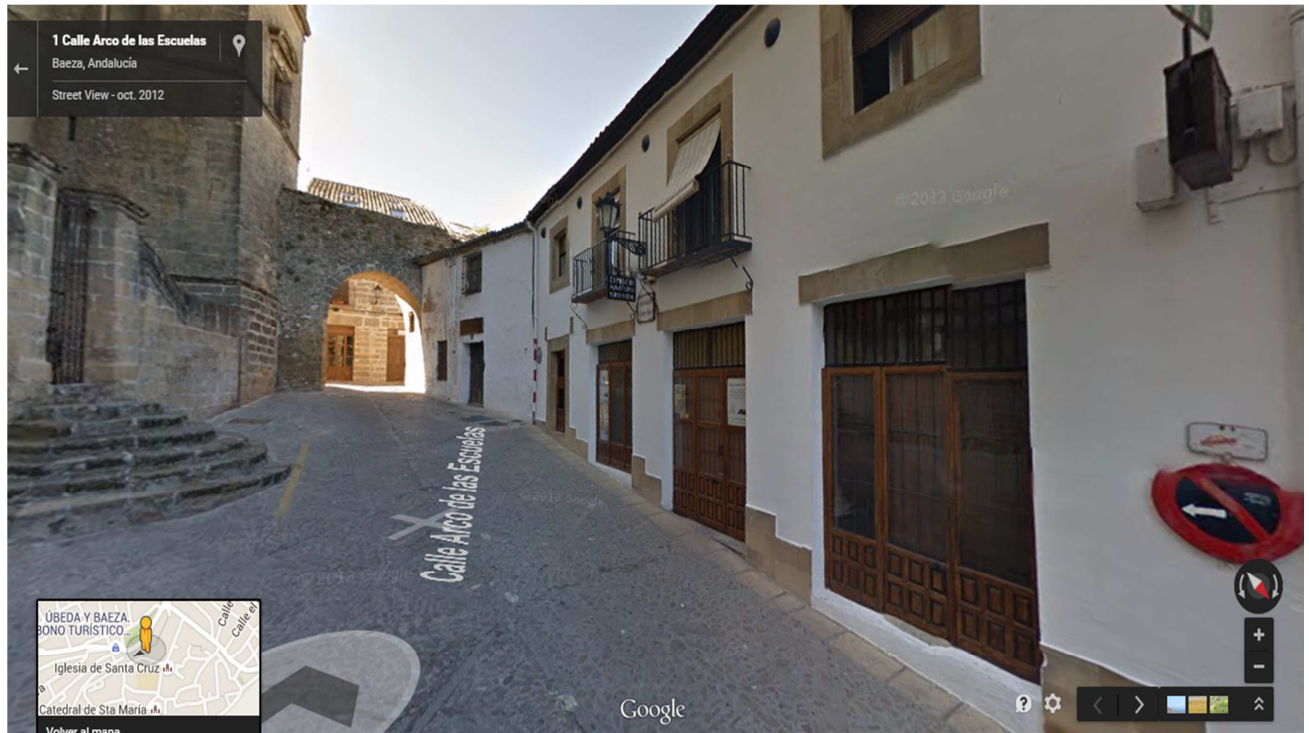
Foto 1: Fachada y localización del local
