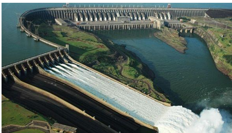
Figura 1 Presa de las Tres Gargantas
