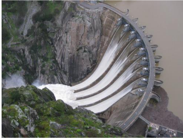
Figura 63: Vertedero que muestra el perfil de Creager.
