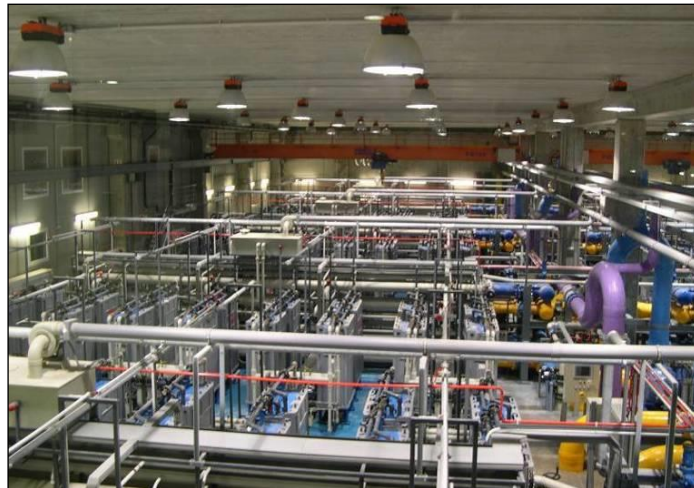
Figura 3.3. Tuberías de PRFV y PP en obra. Planta desaladora por EDR más grande del mundo, Abrera (Barcelona)
