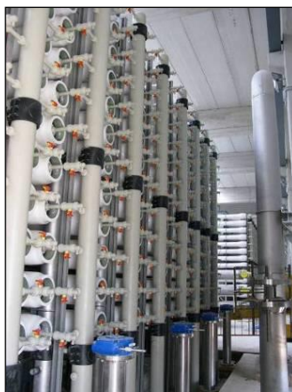
Figura 3.2. Tuberías de PP en obra. Planta desaladora por OI, Skikda (Argelia).
