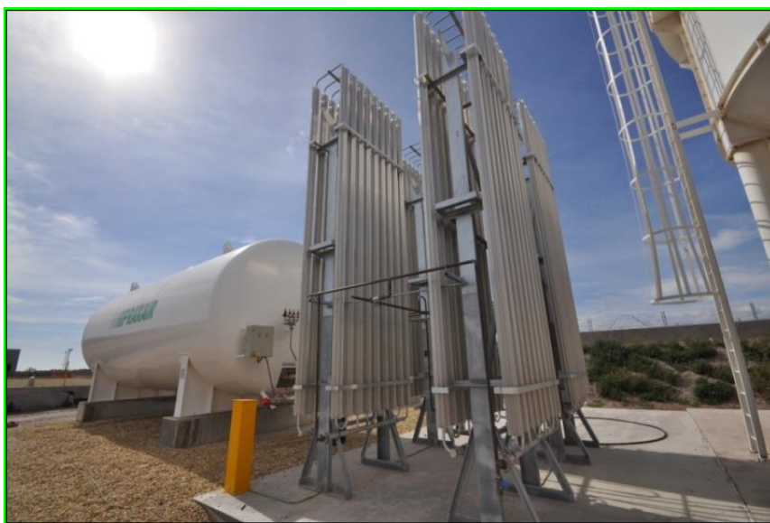
Figura 10.1 Sistema de almacenamiento y Dosificación de CO 2 . Planta desaladora por OI, Águilas (España).
