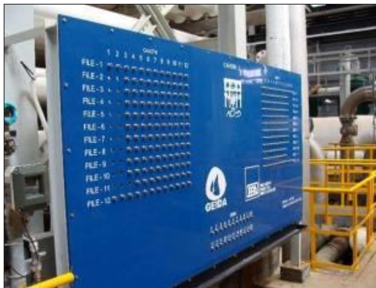
Figura 7.9 Punto central de muestreo de un bastidor. Planta desaladora de agua de mar por OI, Skikda (Argelia).
