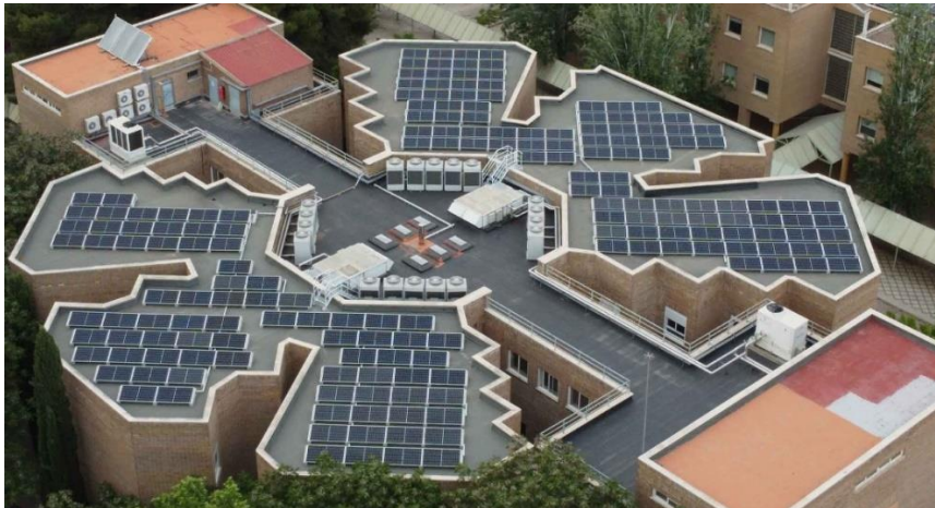
Ilustración 4. Cubierta edificio C3
