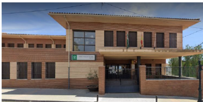
Figura 14. Fotografía del edificio principal del I.E.S. Vera Cruz
