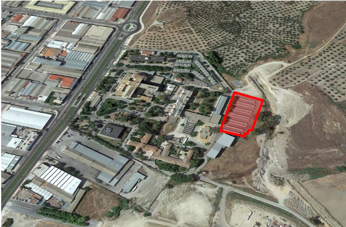
Figura 1. Emplazamiento de la instalación
