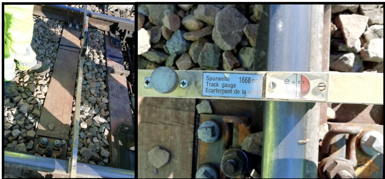
Figura 21: Medición del ancho de vía por parte del autor
