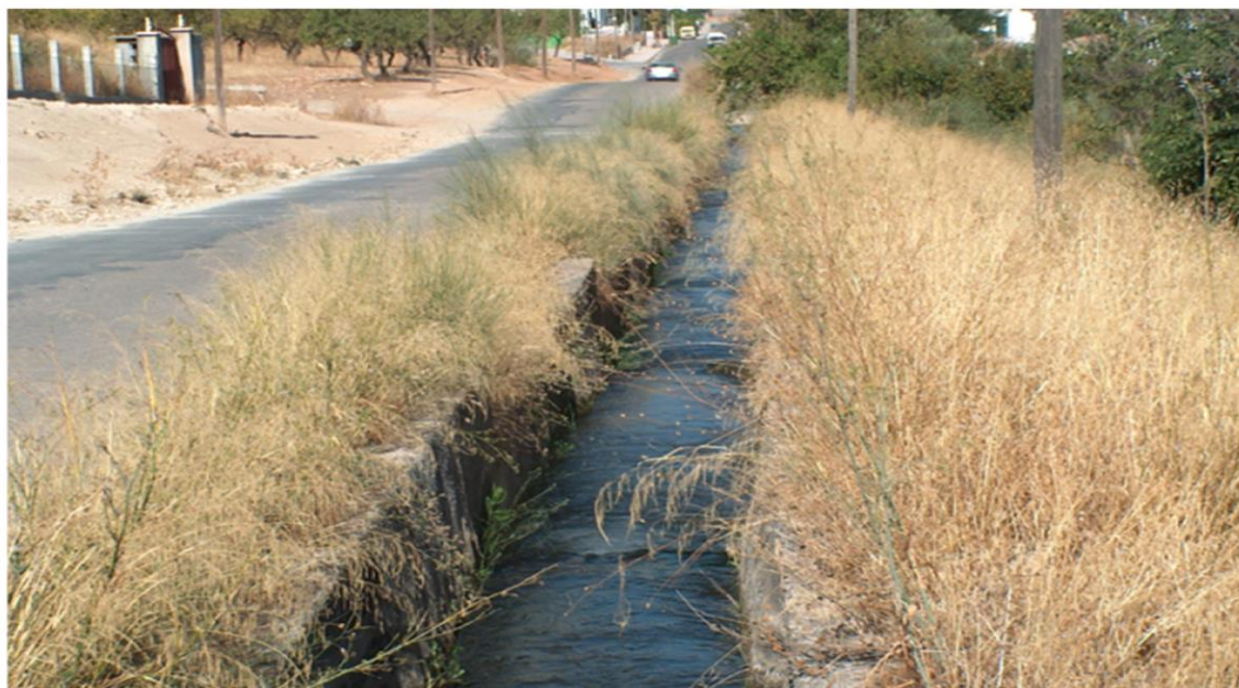
Imagen 8: Foto Inicio del Tramo.
