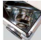
Ilustración 14: Imágenes detalle del recuperador de calor
