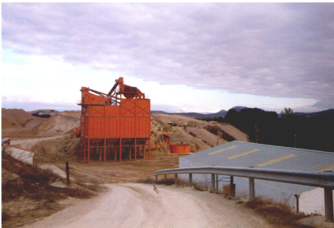
Foto nº3.- Acceso a la planta de machaqueo.
