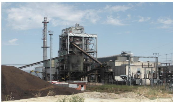
Figura 1. Vista general de la planta La Loma.
