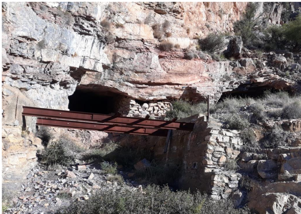
Figura 7.3 Socavón de labores intermedias
