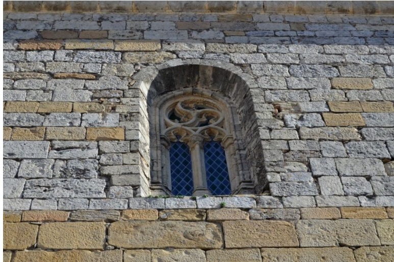
Figura 2.8: Ventana en fachada Oeste.
