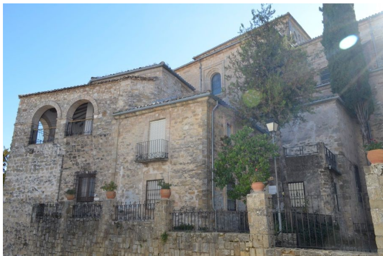
Figura 2.9: Dependencias parroquiales en la fachada Norte.
