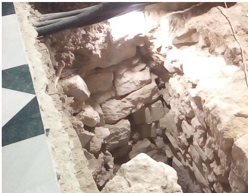
Figura 5.11: Estructura de la cimentación a la izquierda del zuncho.
