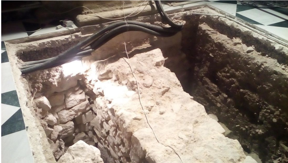
Figura 5.10: Perspectiva de la cata excavada.
