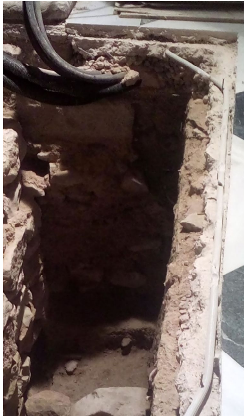
Figura 5.12: Estructura de la cimentación a la derecha del zuncho.
