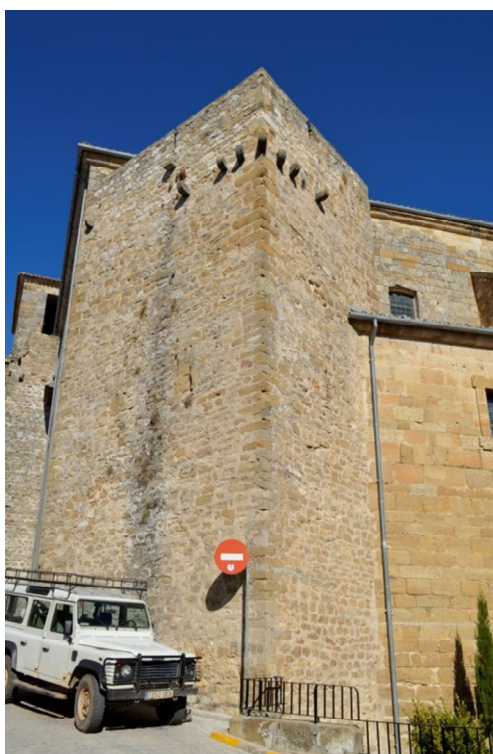
Figura 2.7: Torre entre las fachadas Sur y Oeste.
