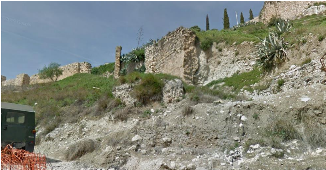
Figura 60. Ampliación bajomedieval de las murallas del castillo de Luque en su ladera sur. Se puede observar como un grueso muro de mampostería irregular se apoya en un lienzo precedente de tapial (Fotografía del autor).
