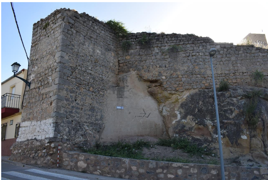
Figura 10. Cara oeste y sur del tramo C (III) (Fotografía del autor).
