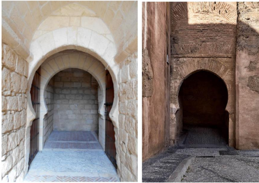
Figura 41. Comparación de la puerta de acceso a la torre del homenaje del castillo de Alcalá la Real (Escudié-Lacroix, 2016-2017: 36) y la puerta de las Pesas de Granada ( https://albaicinparaíso.com/puerta-de-las-pesas/ ).
