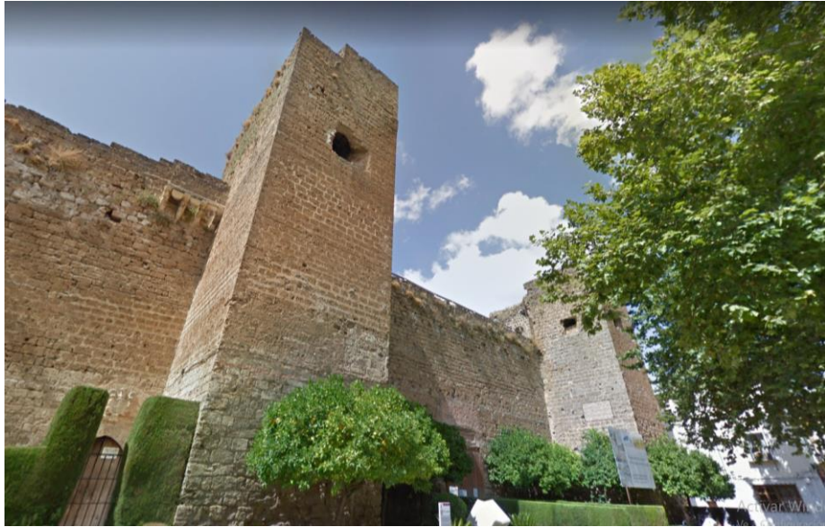
Figura 62. Torres del sector sur realizadas en sillarejo de travertino con aparejo regular, con grandes vanos abocinados (Fotografía del autor).
