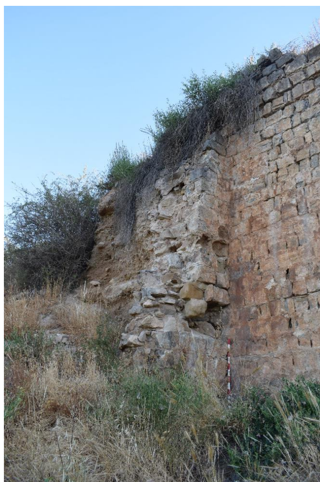
Figura 12. Arranque de la torre noroeste del tramo D (I) (Fotografía del autor).
