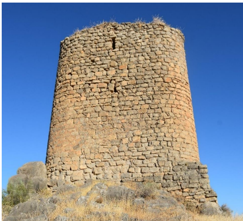
Figura 50. Vista este de la torre del homenaje, con esquinas achaflanadas, en la que se puede observar una torre anterior realizada en otro material en la esquina inferior derecha (Fotografía del autor).
