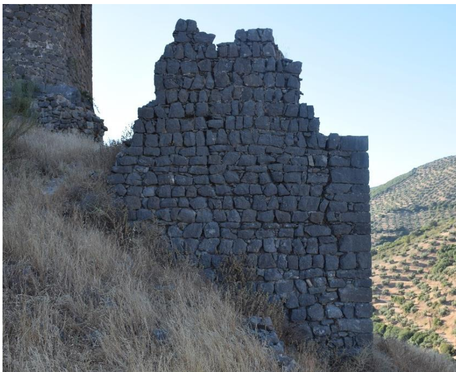
Figura 49. Camisa de mampostería irregular dispuesta en hiladas con cadena de sillarejo, que conforma el cierre oeste de la zona superior del castillo de Víboras (Fotografía del autor).
