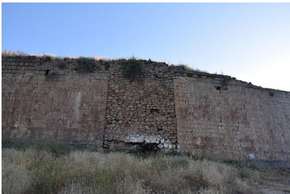
Figura 11. Vista general del tramo D. I (Fotografía del autor).
