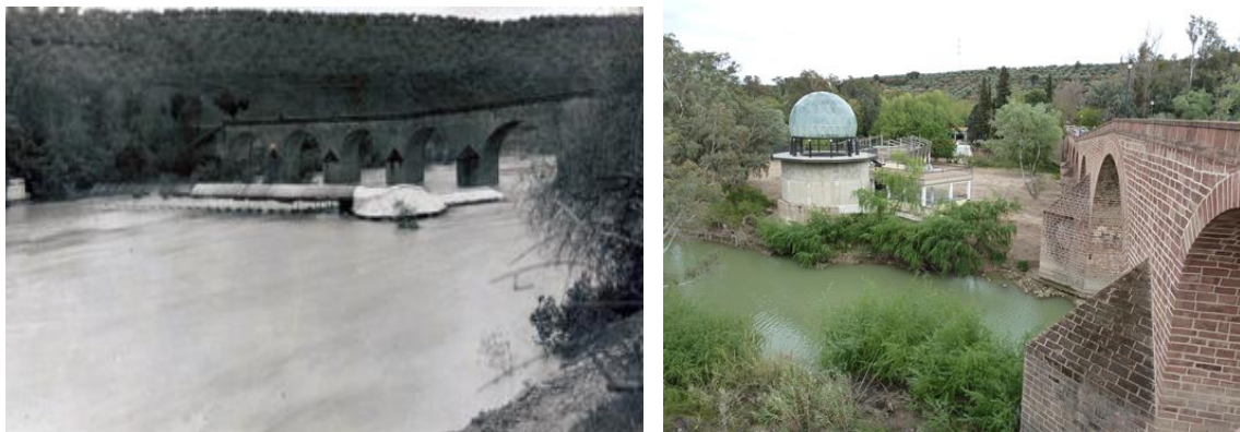
Figura 3.11. Vistas del Puente; a la izquierda se observa una imagen del año 1906 y en la derecha la actual.
