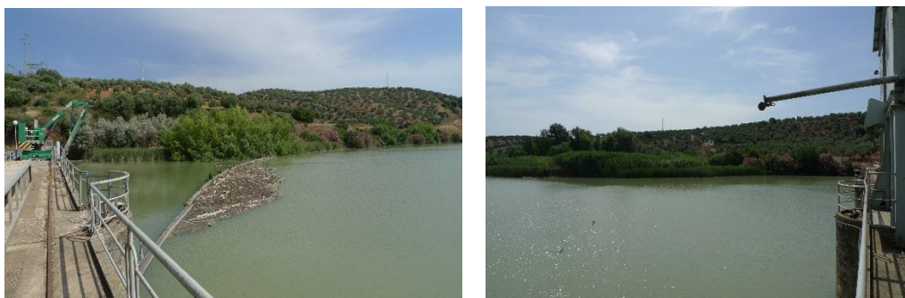
Figura 3.8. Vista de la llegada del río a la presa de Marmolejo.
