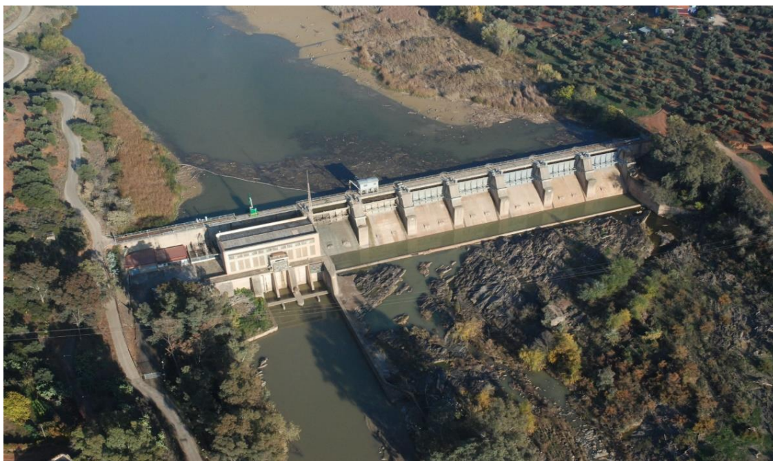
Figura 3.9. Vista aérea de la presa de Marmolejo.
