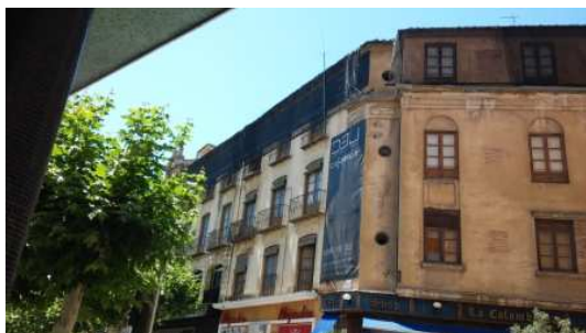
Figura 32. Viviendas del siglo XIX, en proceso de rehabilitación, ubicadas entre la Calle D. Eduardo Arroyo y la Plaza de S. Francisco.
