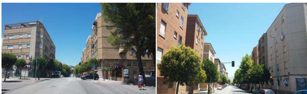
Figura 57. Fotografías de la Avenida de Barcelona.
