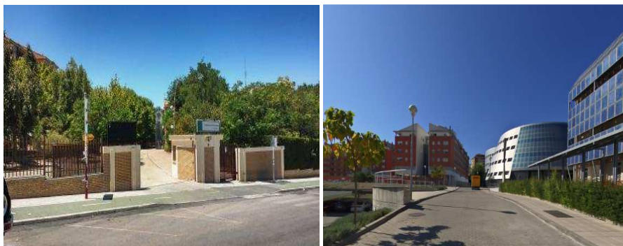
Figura 64. Imágenes del instituto Fuentezuelas, a la izquierda, y de la Universidad de Jaén, a la derecha.
