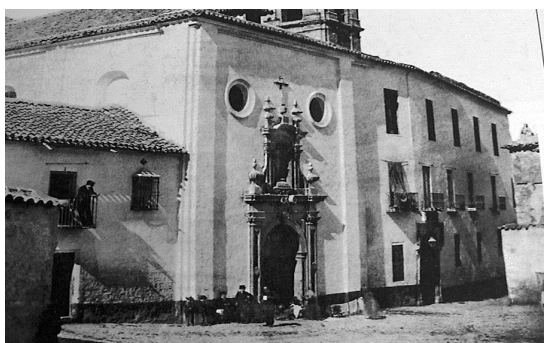
- Figura 17. El hospital San Juan de Dios.
