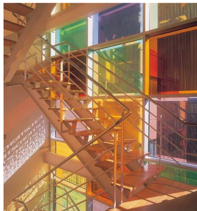
Figura 5.29. Muro Cortina Fotovoltaico. Sede Schott Ibérica, Barcelona. [48]
