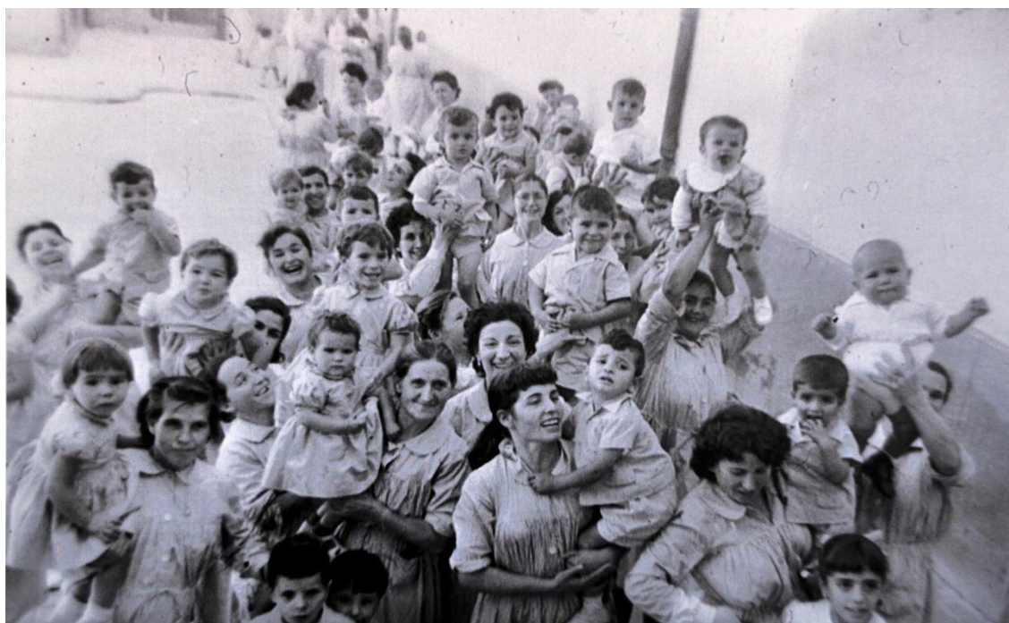
Ilustración 8: Reclusas con sus hijos en la Prisión de Madres Lactantes instalada en Ventas, 1955
