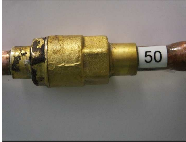
Ilustración 26: Válvula antirretorno
