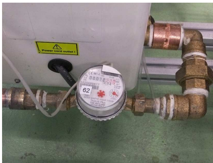
Ilustración 28: Caudalímetro agua de impulsos
