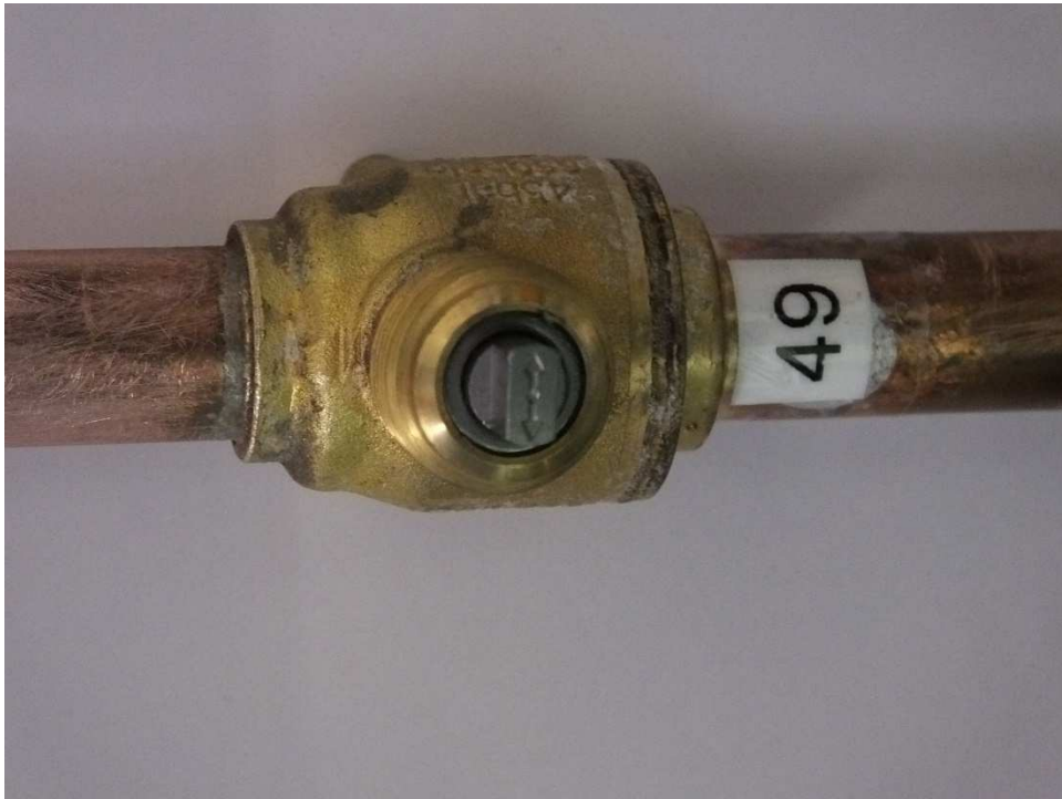
Ilustración 37: Válvula de bola cerrada
