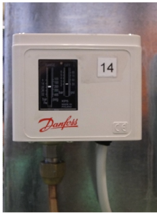
Ilustración 13: Presostato de alta
