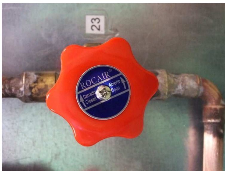
Ilustración 16: Válvula de volante
