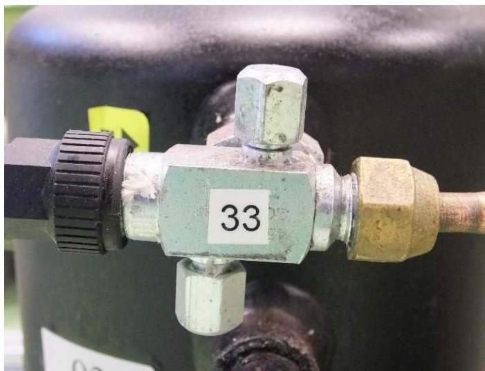
Ilustración 19: Válvula Rotalock
