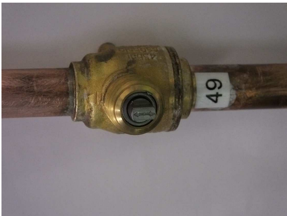
Ilustración 38: Válvula de bola abierta
