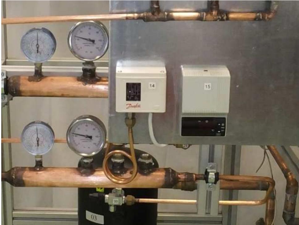
Ilustración 54: Presostato de alta y Termostato
