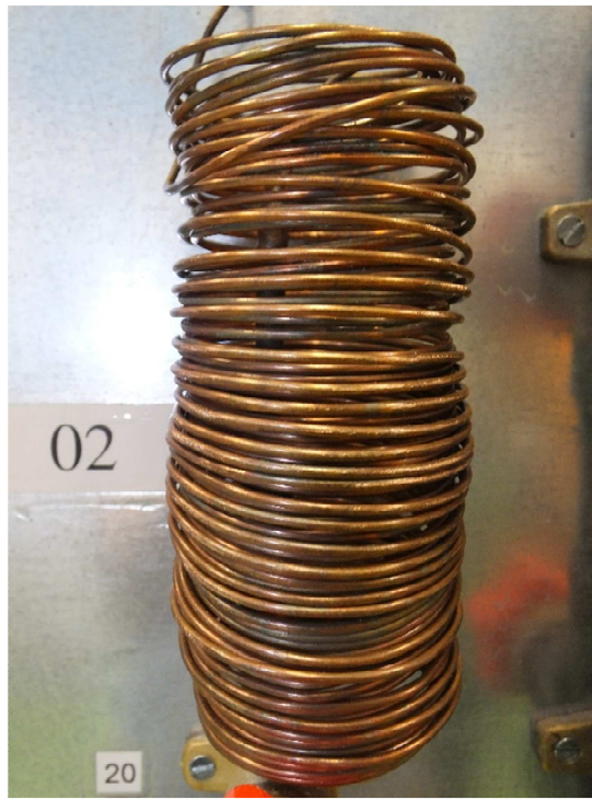
Ilustración 2: Tubo capilar
