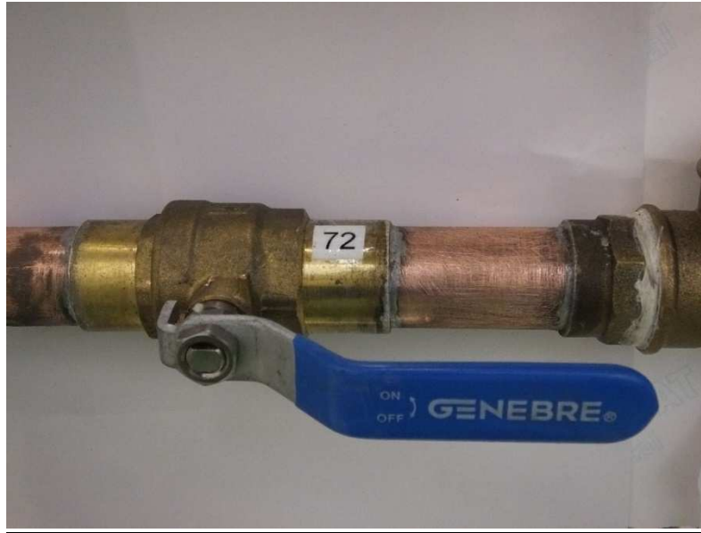
Ilustración 29: Válvula de bola (Agua)
