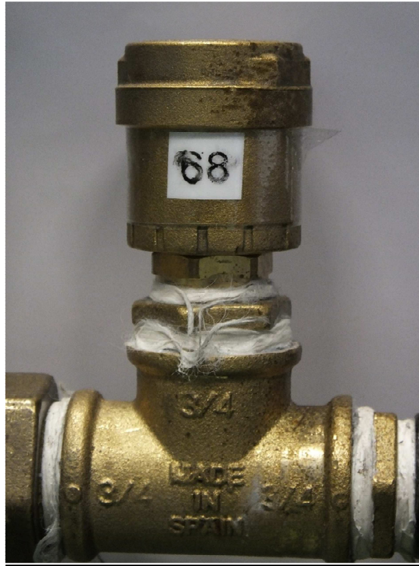
Ilustración 32: Purgador de aire
