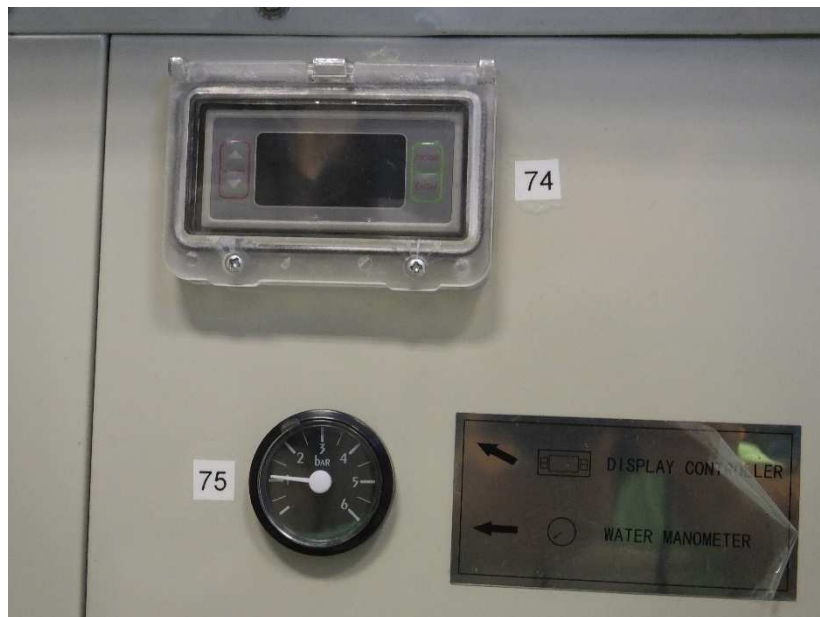
Ilustración 33: Display y manómetro Chiller
