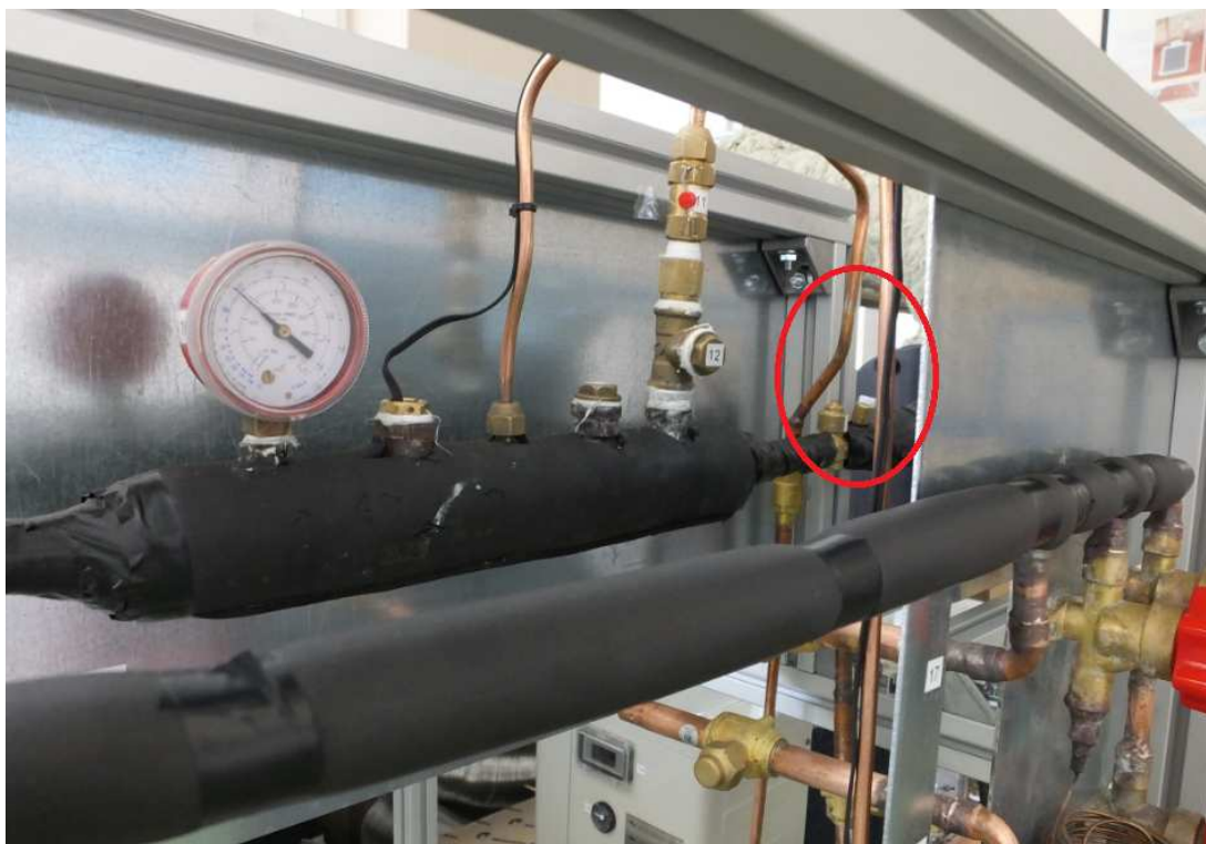
Ilustración 34: Localización válvula de obús 10
