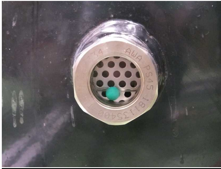
Ilustración 20: Visor de líquido depósito
