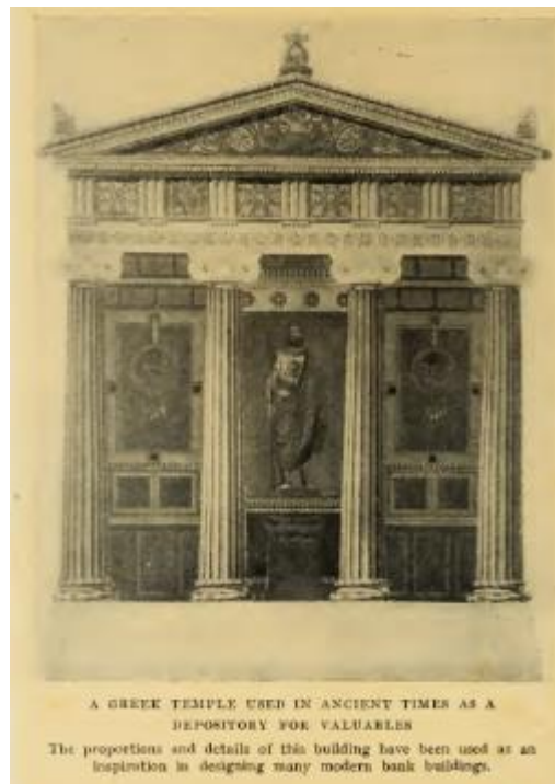
Imagen 7. Banco griego en un templo. Fuente. Banking through the ages. P. 32
