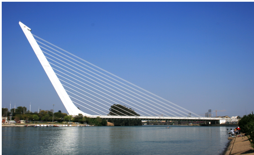
Ilustración 5. Puente del alamillo. (Sevilla) Fuente: https://es.m.wikipedia.org/wiki/Archivo:Puente_del_Alamillo_en_Sevilla.jpg
