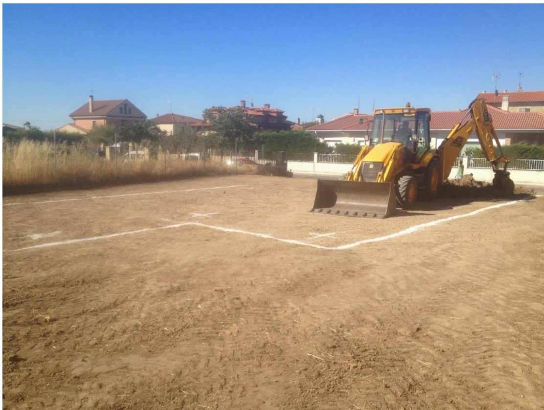
Ilustración 6. Fuente: SoloArquitectura.com . Limpieza y nivelado
