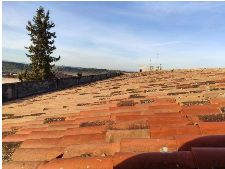
Figura 33. Cubierta del edificio A.
