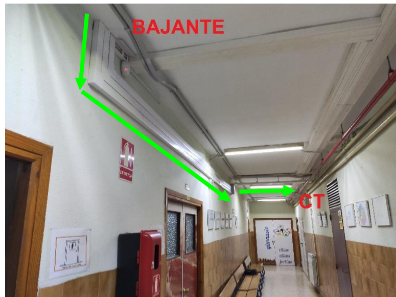
Figura 30. Bajante de la nueva canalización.
