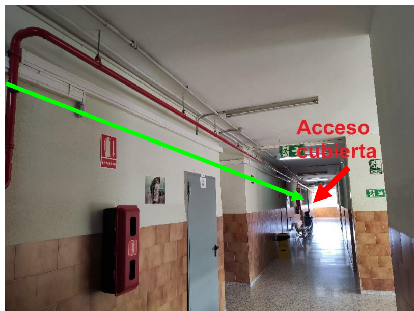
Figura 31. Nueva canalización planta tercera hasta el acceso a la cubierta del edificio A.
