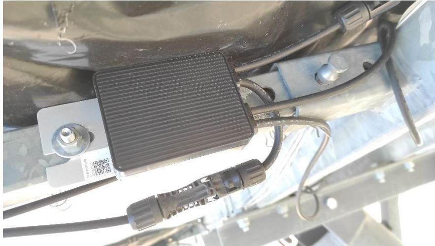
Figura 19. Optimizador de Potencia HUAWEI SUN2000 450W
