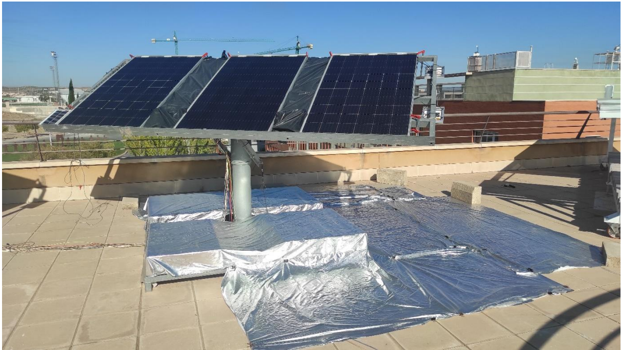
Figura 30. Estructura 2 Con Sobreado de 10% y Suelo Potenciado (Parte Delantera)
