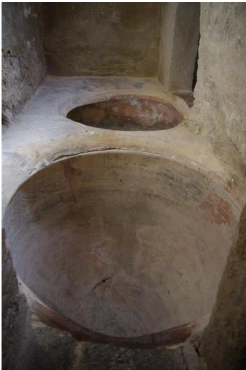
Fig. 29. Interior Baños Árabes. Sala caliente 8 .
