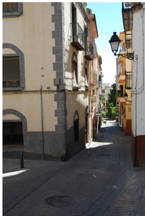
Fig. 16. Calle Arroyo de San Pedro.
