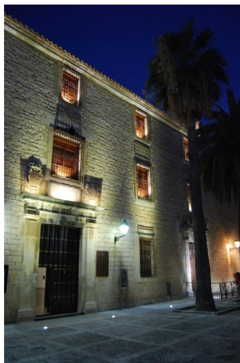
Fig. 26. Palacio de Villadomardo y Baños Árabes
