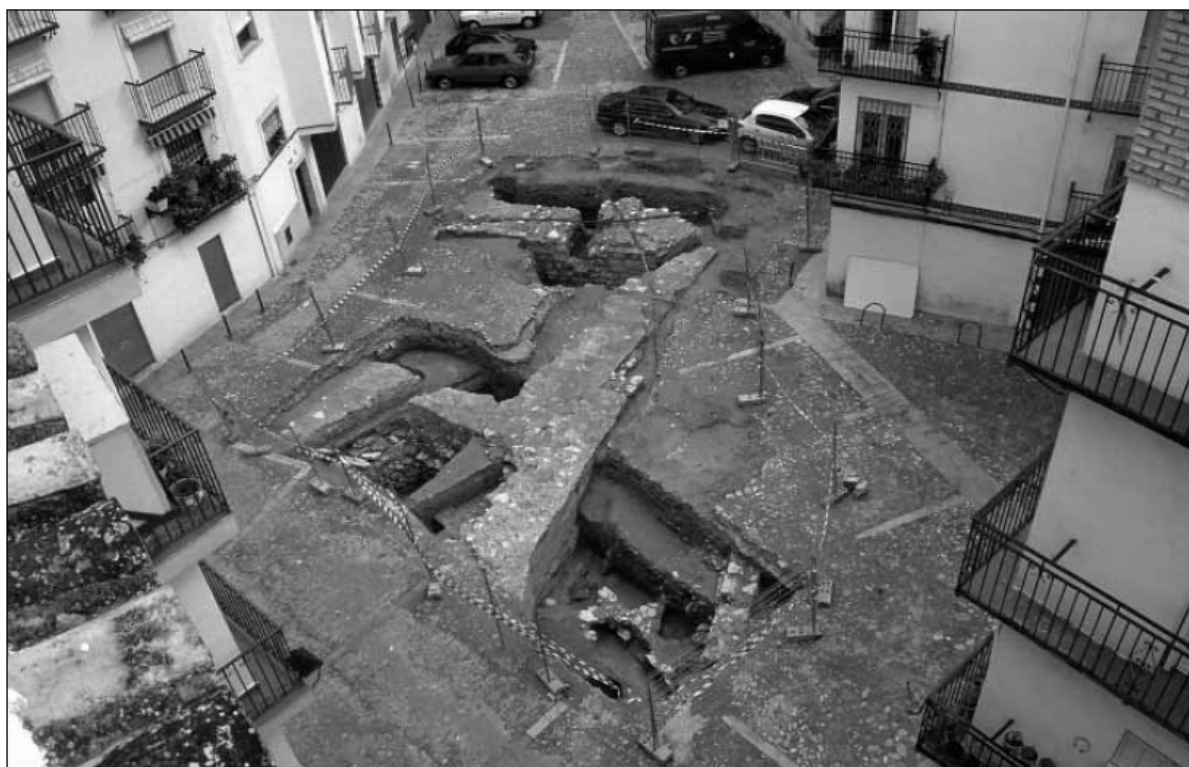
Fig. 42. Vista general de la intervención 9 .
