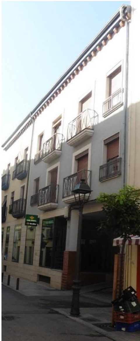
Figura 1. Fachada del edificio.
