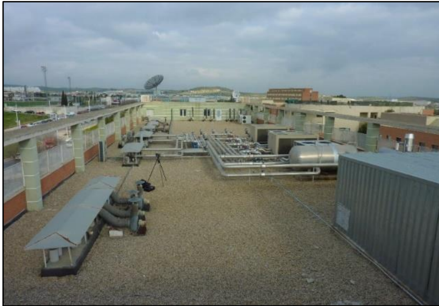
Figura 8. Fotografía de la azotea (Fuente: Elaboración propia)
