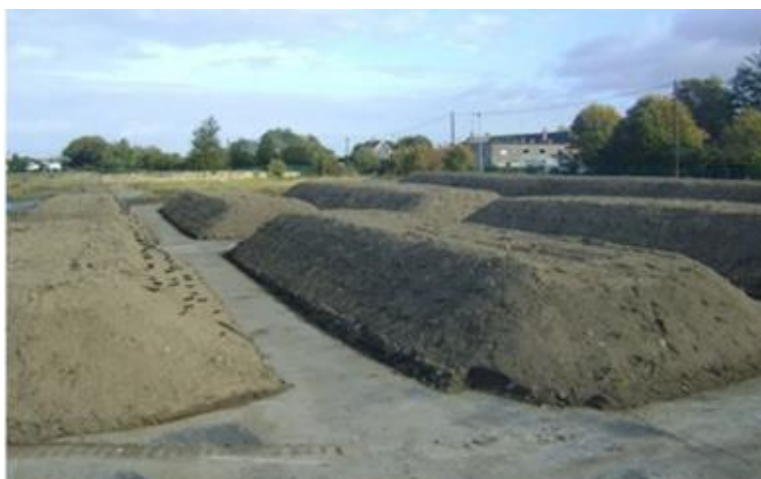
Figura 3.2. Ejemplo de Biopila (Germaine et al. , 2015).
