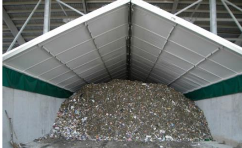
Figura 10. Túnel de compostaje
