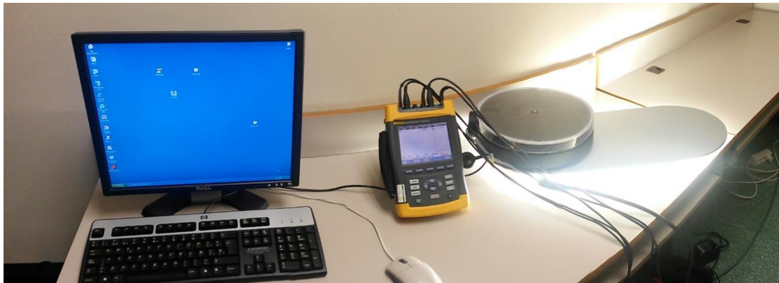
Figura 2.29 Ejemplo de set-up característico de medición parámetros eléctricos.
