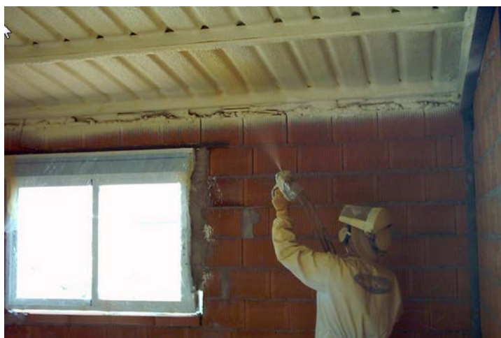
Figura 21 – Instalación de espuma de poliuretano aislante mediante proyección.
