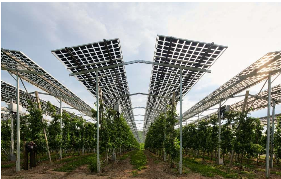
Figura 6 Agrovoltaica overhead. Fuente: [9]
