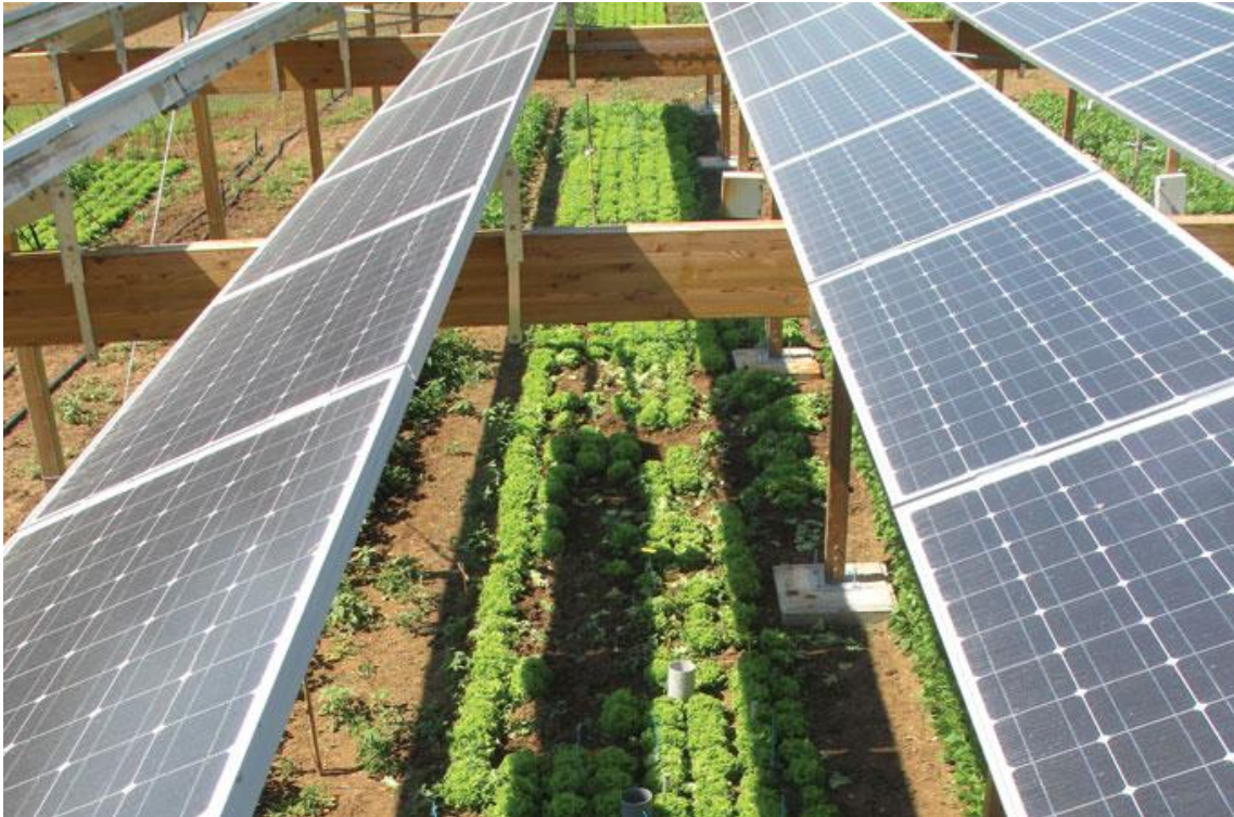
Figura 5 Agrovoltaica interspace. Fuente: [8]
