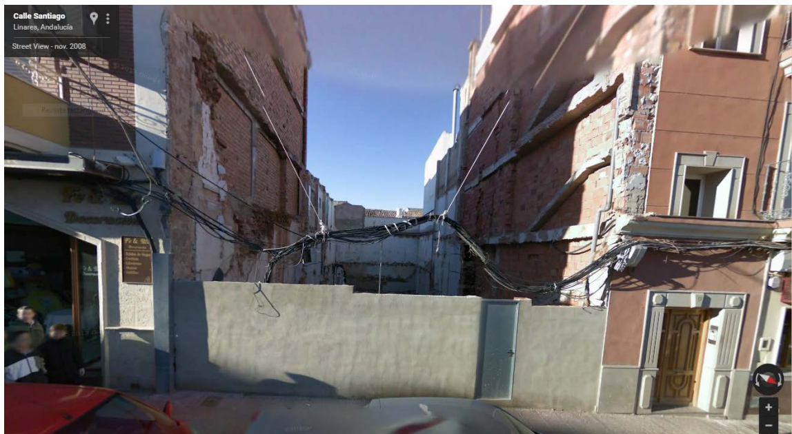
Figura 4. Fachada antes de obra
