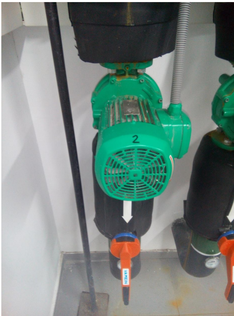
Ilustración 4. Bomba aceleradora marca WILO, modelo IPL-32/110-0,75/2
