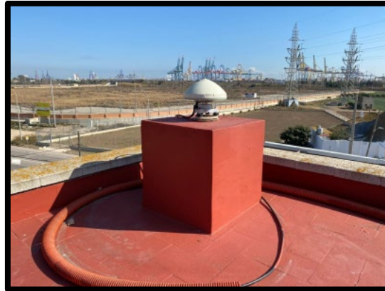
Fig. 5: Ubicación sobre pilar de la estación VCIA.
