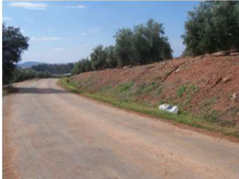
Vista de desmontes excavados en la formación de margas arenosas T G1 .
