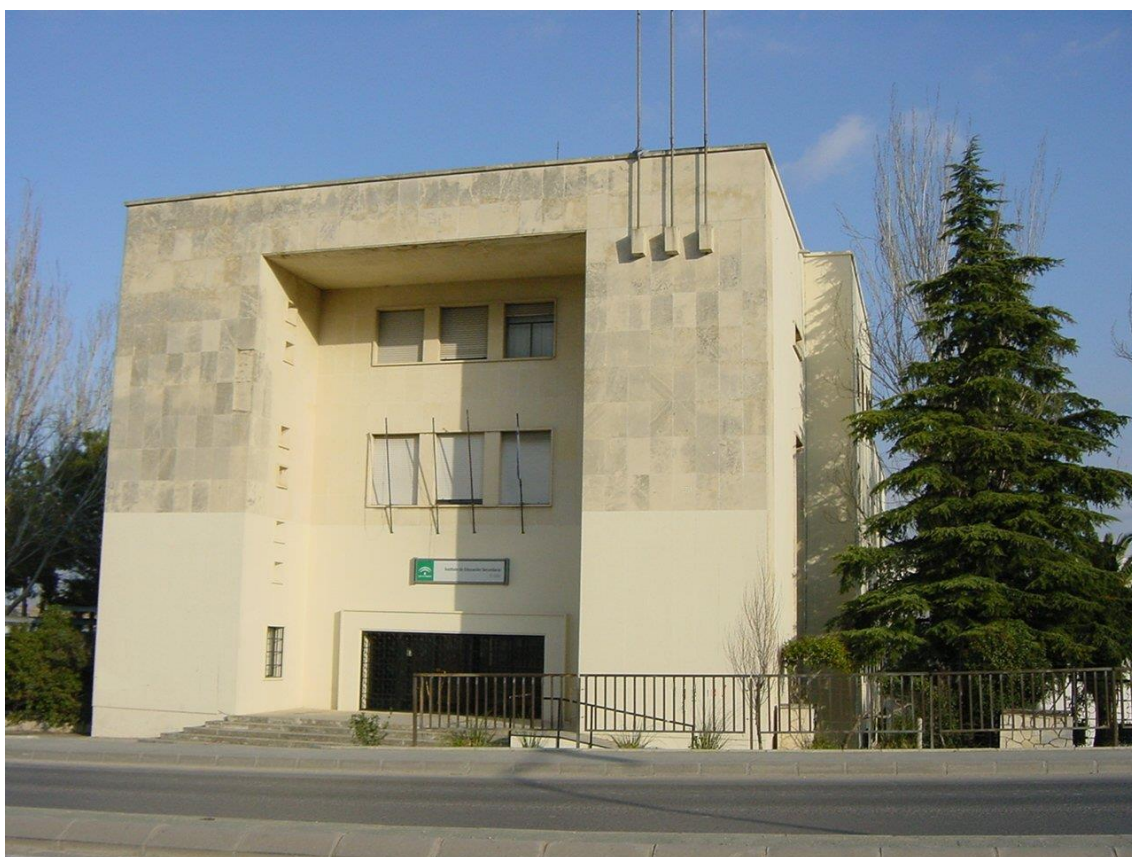
Imagen 2: Fachada I.E.S. El Valle. Fuente: http://www.juntadeandalucia.es/averroes/centros-tic/23700271/helvia/sitio/upload/img/afachada6.jpg Rescatado el 27/05/2019.
