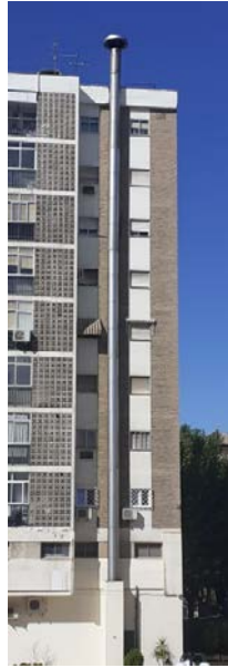
Figura 4.7 Chimenea (Fuente: Elaboración propia)
