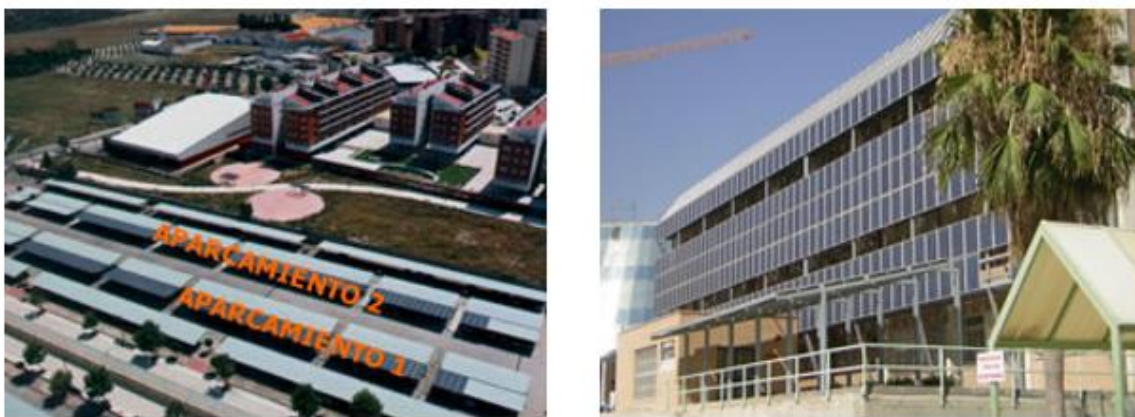
Figura 1.4. Fotografías del sistema FV instalado en la UJA en 2003.
