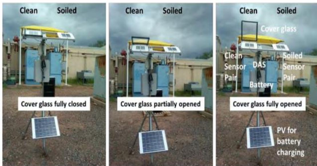
Figura 3.4. Etapas de funcionamiento de la Waterless Soiling Station [42].
