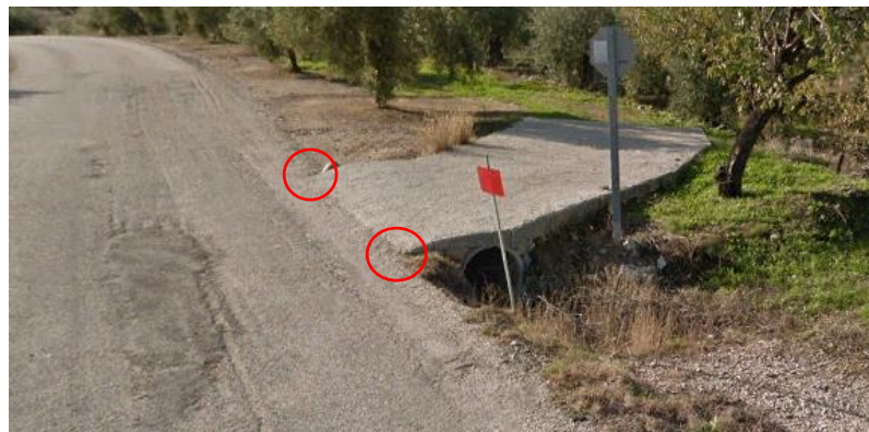
Ilustración 2.27. Puntos singulares en terreno para puntos de control
