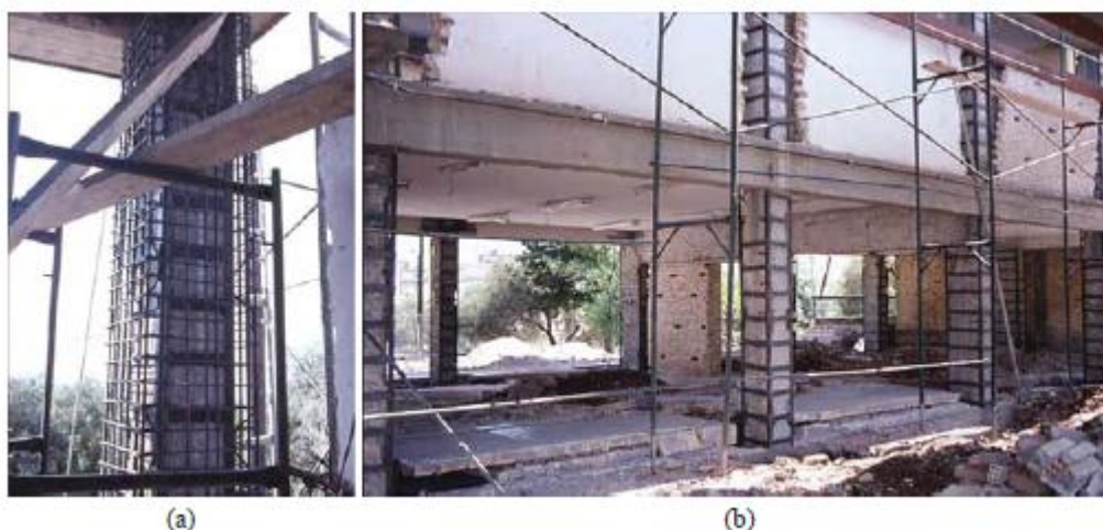
Figura 2.31. Chaquetas de acero construidas in situ con ángulos de esquina y correas horizontales.
