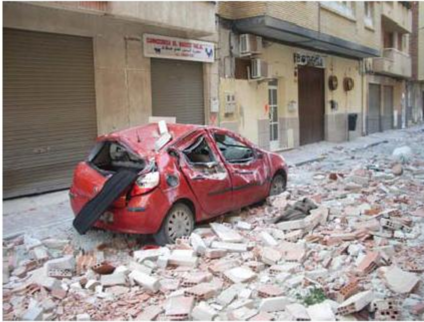
Figura 2.24. Un automóvil dañado por la caída de parapetos de cubierta en la Calle Galicia.
