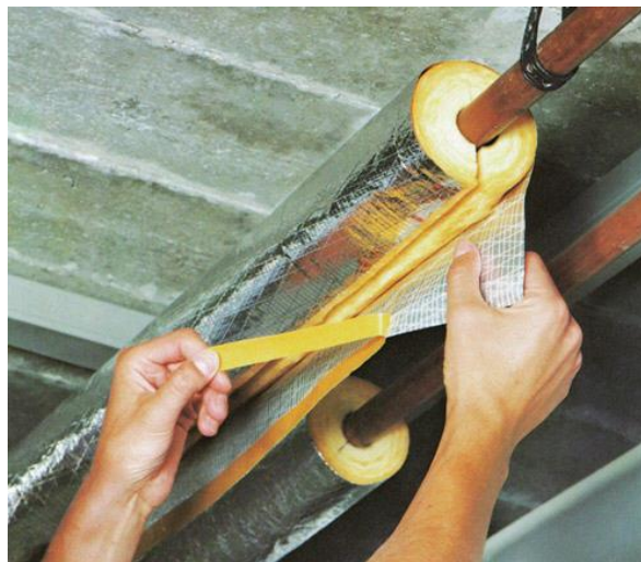
Ilustración 25: Cubretuberías BT-LV (Fuente: www.five.es )
