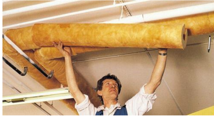
Ilustración 26: Coquillas BT-LV (Fuente: www.five.es )
