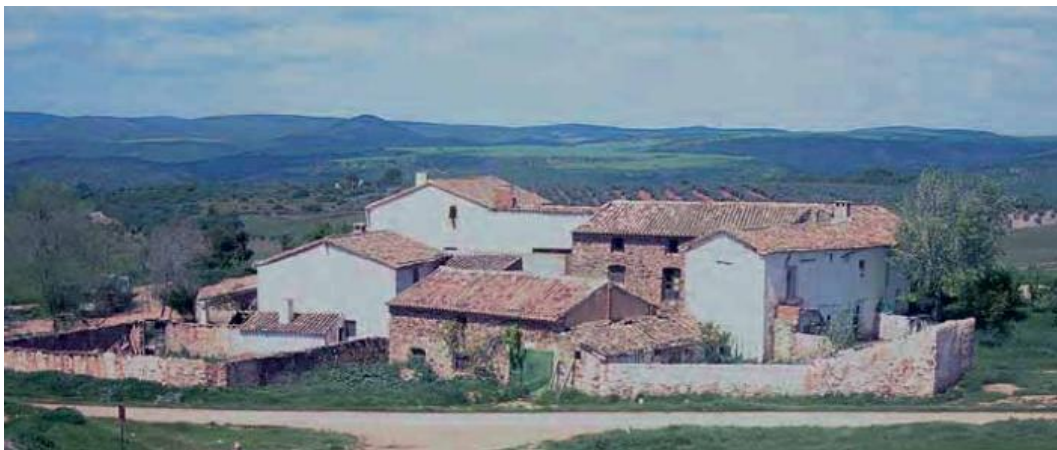
El cortijo de las Tiesas, Puerta de Segura. Fuente: Berges Torres, J y Córcoles de la Vega, J. L. (2018). Cortijos, Haciendas y Lagares de la Provincia de Jaén . Sevilla: Junta de Andalucía. Consejería de Fomento y Vivienda.
