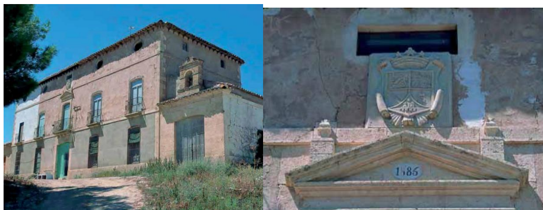
El cortijo de Pedro Marín, Bedmar. Fuente: Berges Torres, J y Córcoles de la Vega, J. L. (2018). Cortijos, Haciendas y Lagares de la Provincia de Jaén . Sevilla: Junta de Andalucía. Consejería de Fomento y Vivienda.
