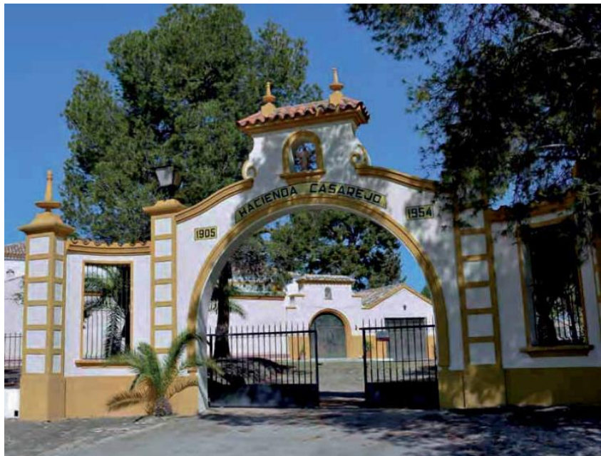
La hacienda Casarejo, Mancha Real. Fuente: Berges Torres, J y Córcoles de la Vega, J. L. (2018). Cortijos, Haciendas y Lagares de la Provincia de Jaén . Sevilla: Junta de Andalucía. Consejería de Fomento y Vivienda.
