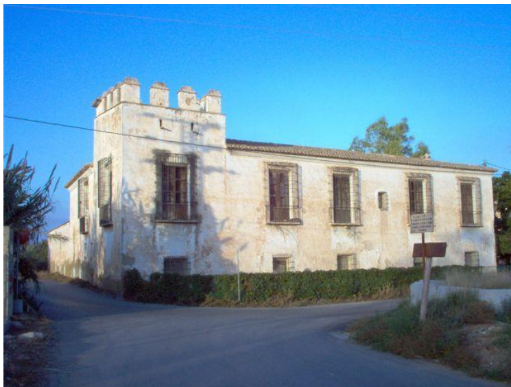
Alquería de la Torre de Benicalap (Valencia) Fotografía: Antonio Marín Segovia
