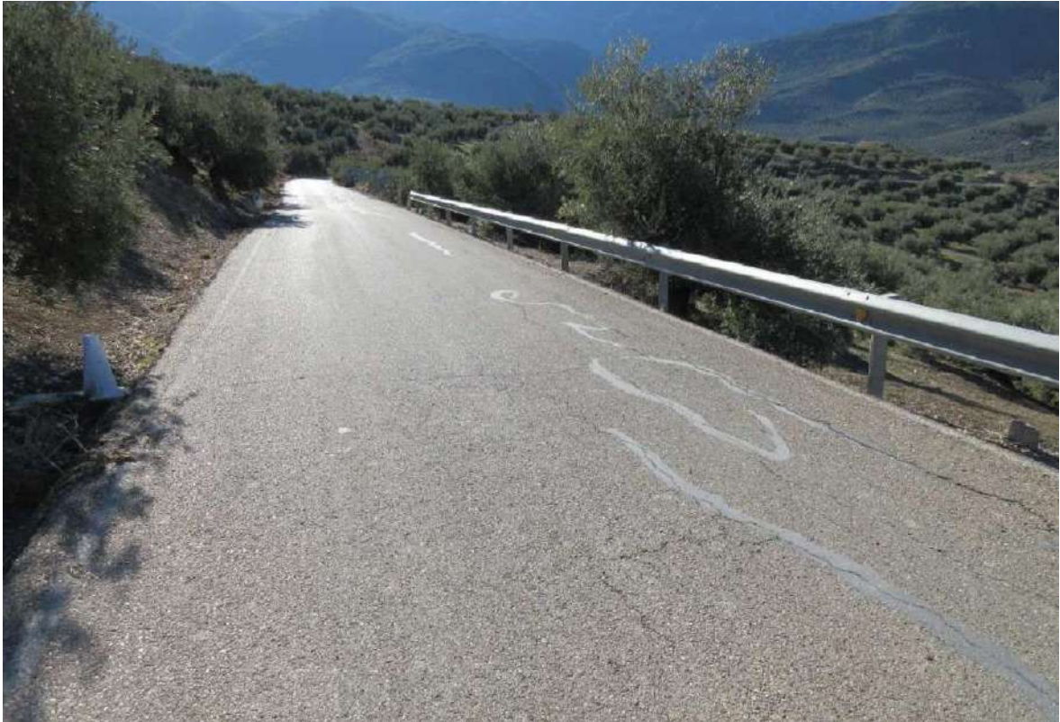
Figura 3.9: Detalle de asentamientos de carácter diferencial.
