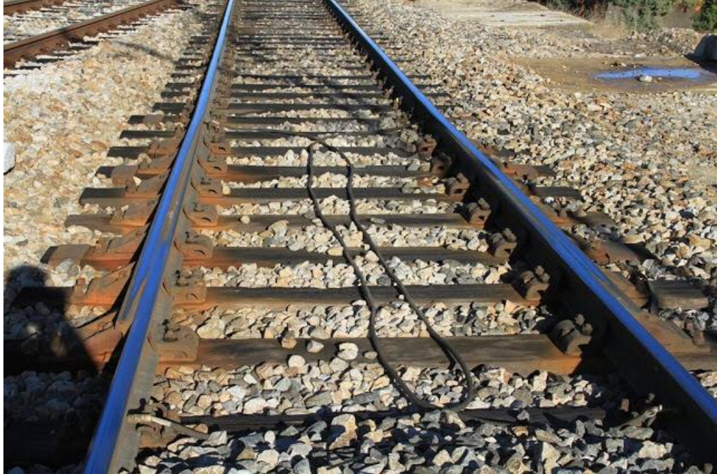
Figura 20. Aparato de dilatación en la estación de Pinar de las Rozas (Madrid)
