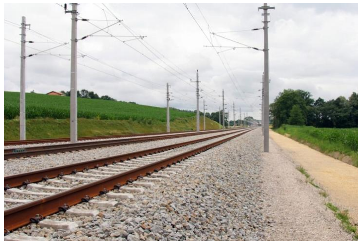
Figura 10. Vía convencional de balasto.
