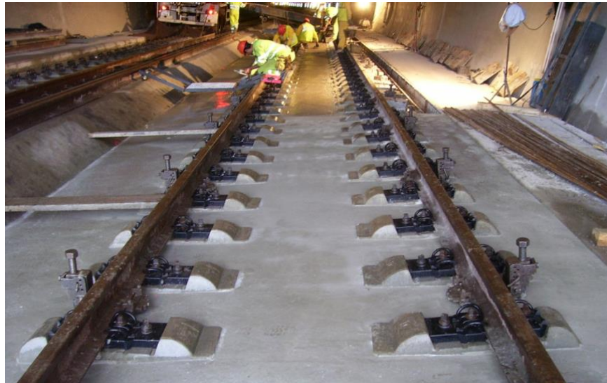
Figura 11. Hormigonado de vía en placa con encofrado deslizante.
