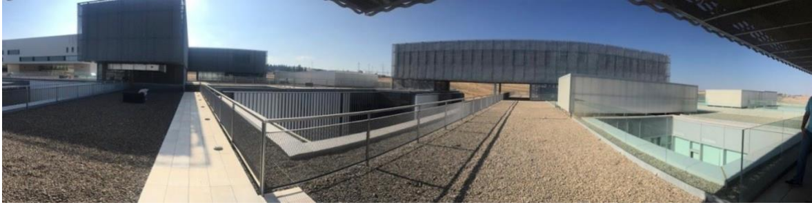
Figura 30. Panorámica con acceso a la cubierta Oeste desde la cubierta Este.
