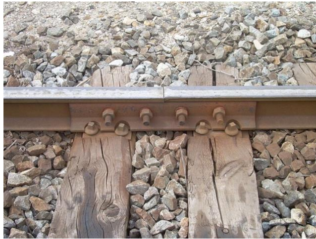
Figura 19. Junta de carril con sujeción rígida.
